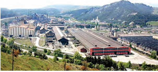
Karabük Demir Çelik Fabrikası
